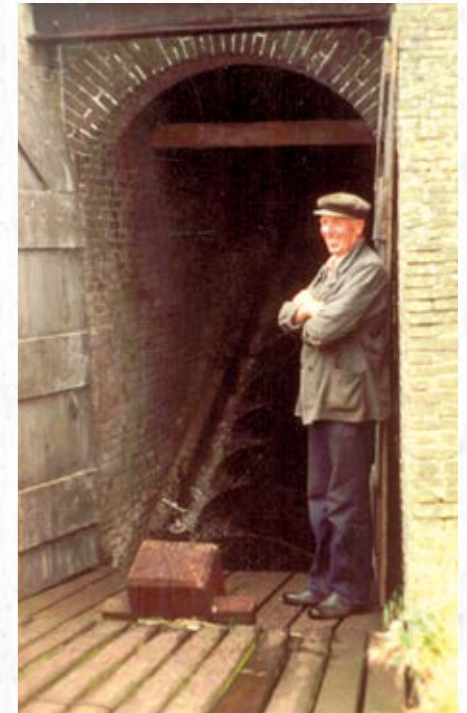
Willem van der Pouw Kraan bij de vijzel van de Lijkermolen, die het water ruim vier meter opbrengt.
