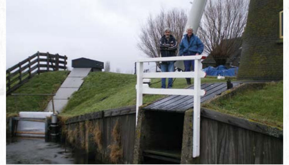
Anton (links) en Henk Vermeij bij de molen; links het elektrisch gedreven vijzelgemaal.
